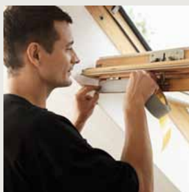
Ventilatiefoam vervangen
